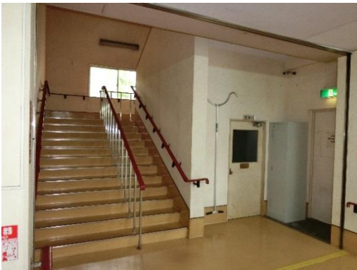
北館 東側 階段の手すり
