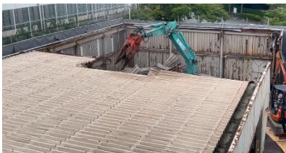
① 屋根の取り壊し
