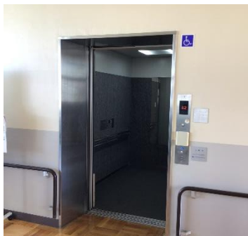
①車いすが4台入ることが可能です。
