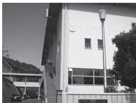
体育館屋外壁面太陽電池式大型時計 (直径 45cm)
