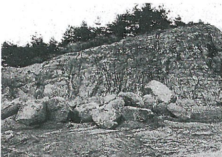
平尾山古墳群内の破壊された古墳の石材
