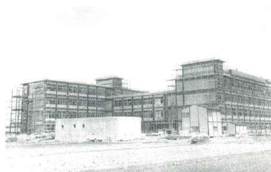
1 期工事 南西側より
